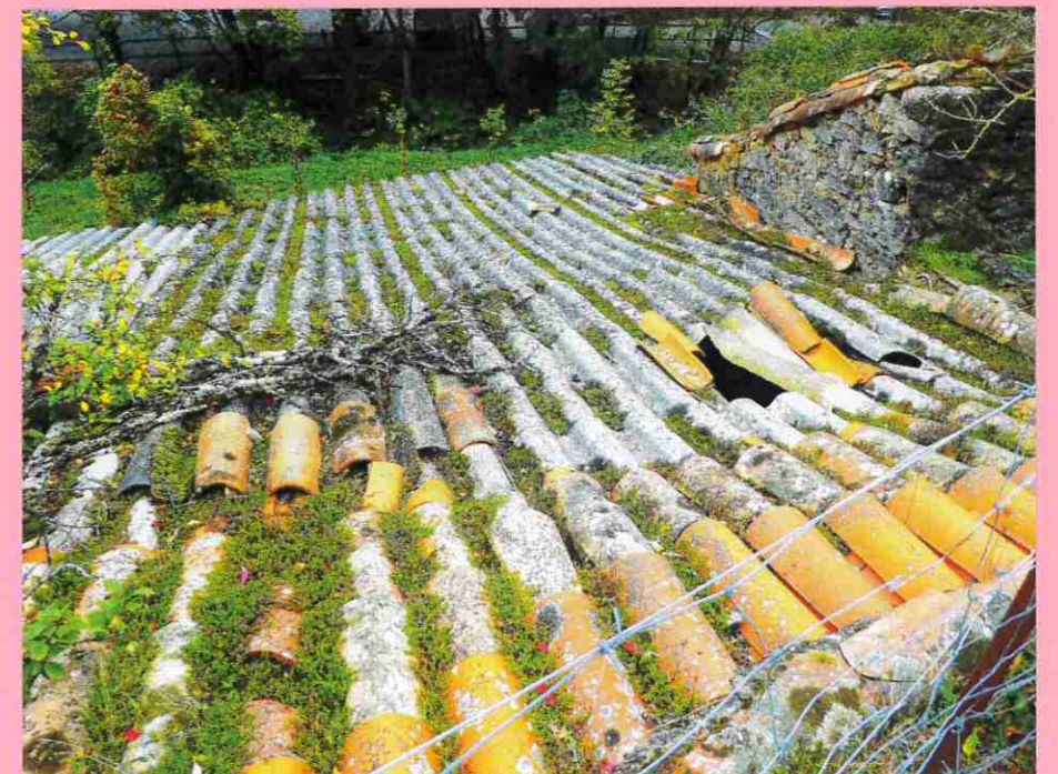
TOITURE AMIANT-CIMENT
